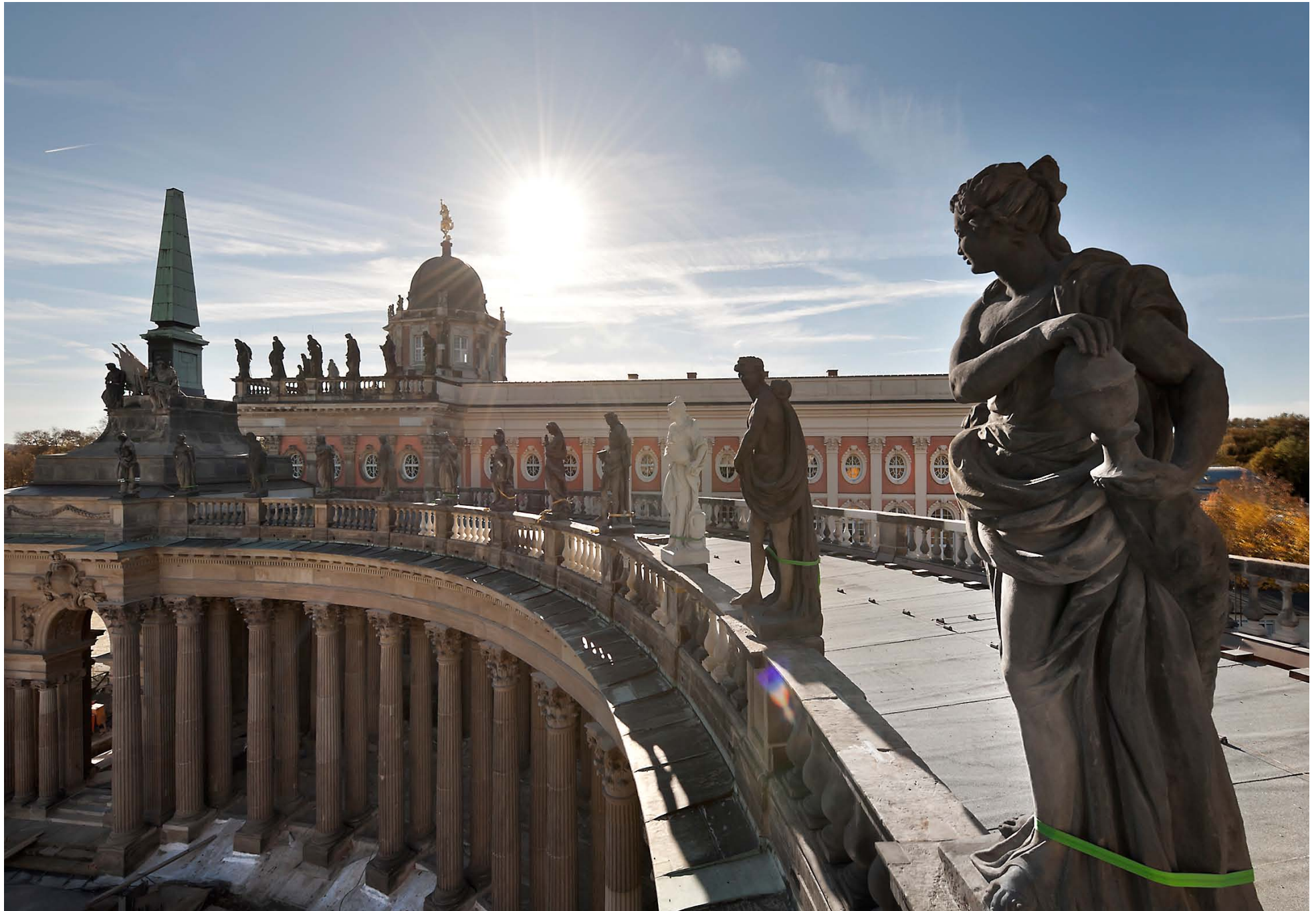
SPSG – Kolonnaden Potsdam
