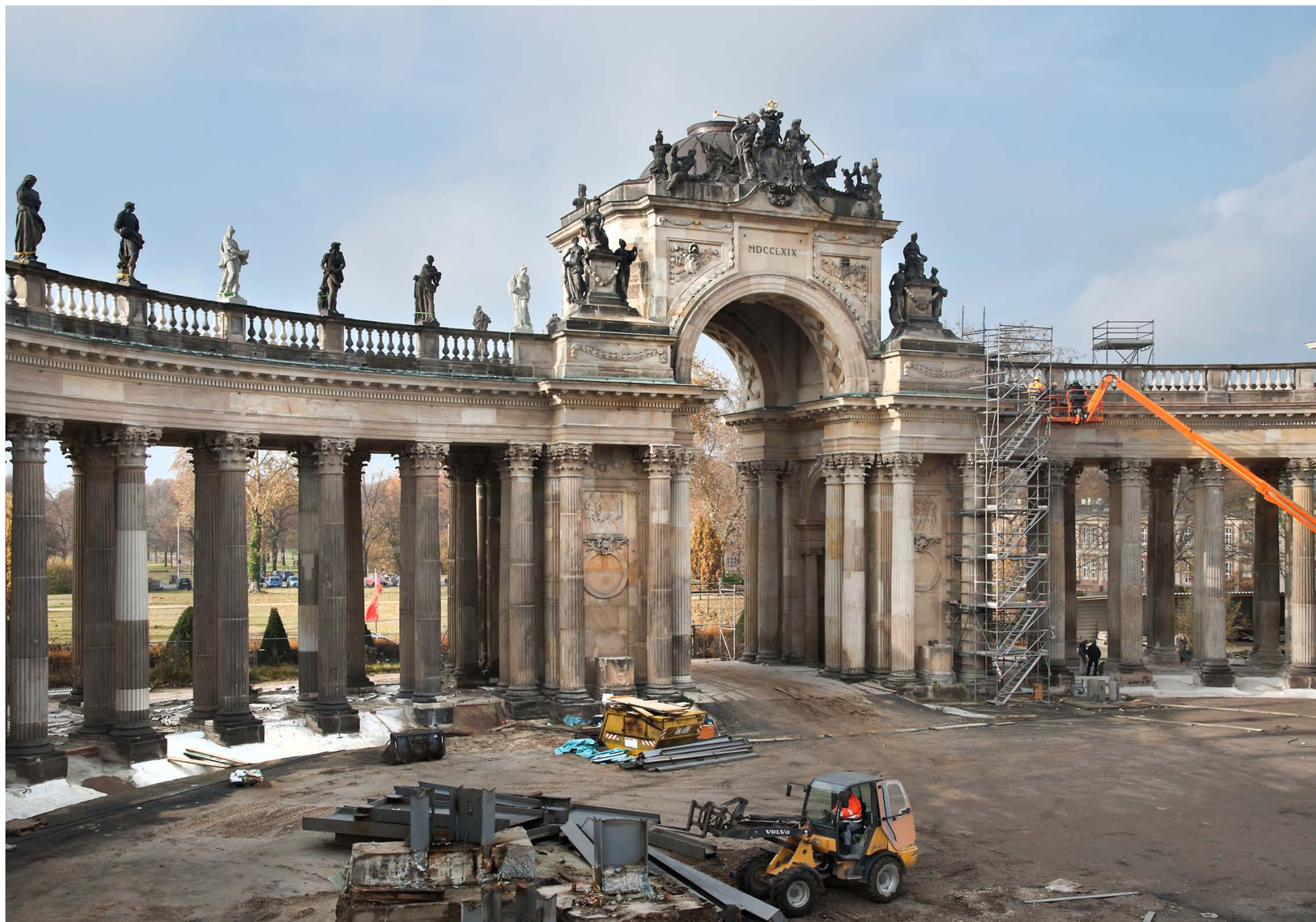
SPSG – Kolonnaden Potsdam
